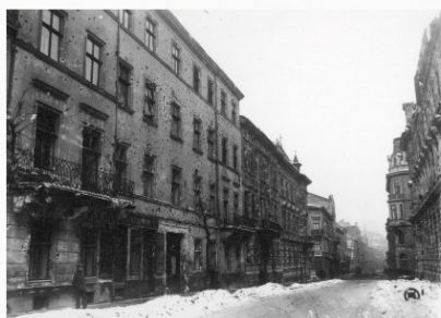
Ulica Sykstuska we Lwowie. Na elewacjach budynków widoczne ślady po pociskach z broni ręcznej i maszynowej. Lwów, 1919 rok.
